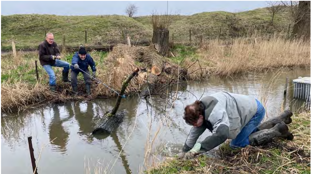
Tijdens de zomerstorm in 2023 was een grote populier over de sloot gevallen. Delen van de boom die in het water lagen, zijn pas in 2024 uit het water gehaald in opdracht van Recreatieschap Spaarnwoude. Om het vossenraster te kunnen plaatsen moest een stronk van de oever gesleept worden / Johan Stuart
